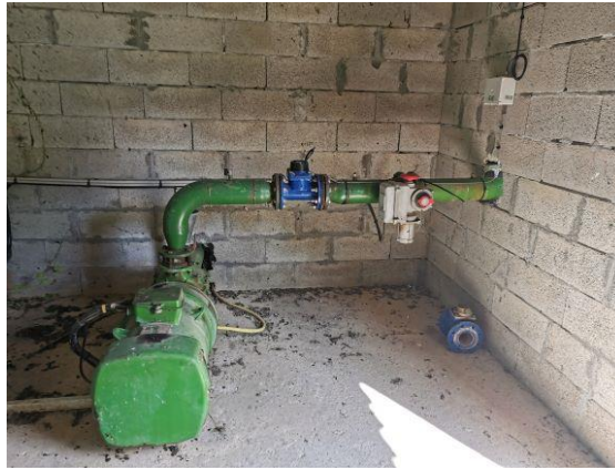
Figure 9 : Compteur équipé d'un boîtier de télérelève (source : Cogesteau, Charente)
